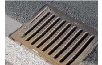
Privilégier l'utilisation généralisée de bordures basses de type A1 (en biseau) au niveau des avaloirs intégrés au trottoir, en veillant à éviter les grilles et entonnoirs et à assurer des raccordements de qualité entre la chaussée et le caniveau.
